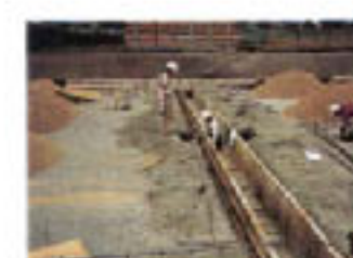
排水パイプ取付
