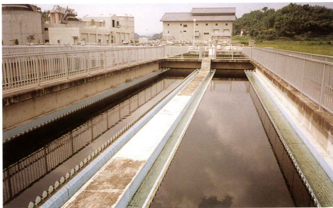
越流堰の施工例
